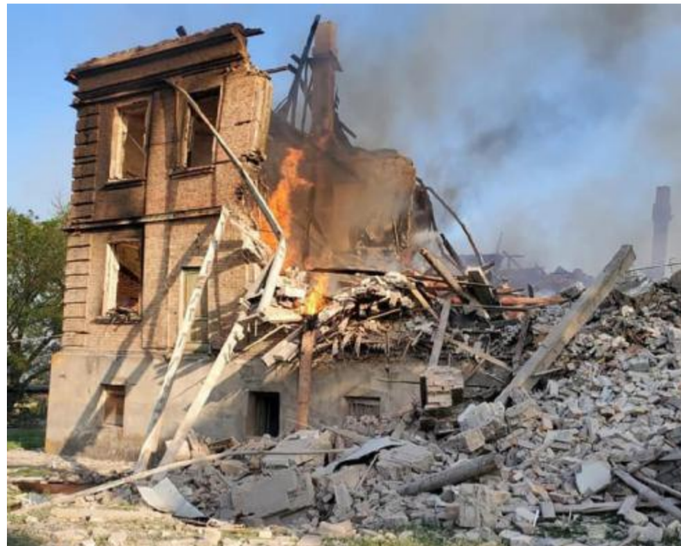
Lugansk Un edificio distrutto dai bombardamenti
